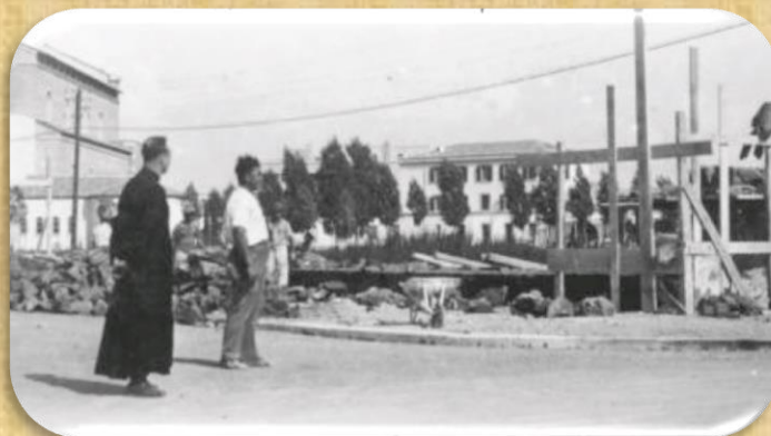
Don Armando Alessandrini vigila i lavori della costruzione dell’Oratorio.
